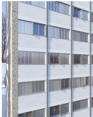
180 Logements réhabilités en site occupé – Rennes (35) 1 130 menuiseries pvc gris teinté dans la masse
