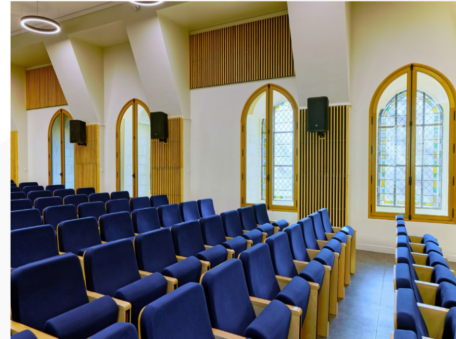
12 fenêtres en ogive en chêne lasuré - Lycée Henri IV, Paris (75) Réalisées sur-mesure par les équipes du site bois de Guillac
